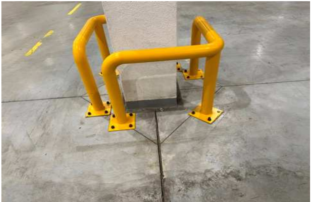
Fotografia 4 Oslona rurowa słupów do demontażu i ponownego montażu po remoncie podłogi. Widoczna fakturowana tynku (baranek) na słupie
