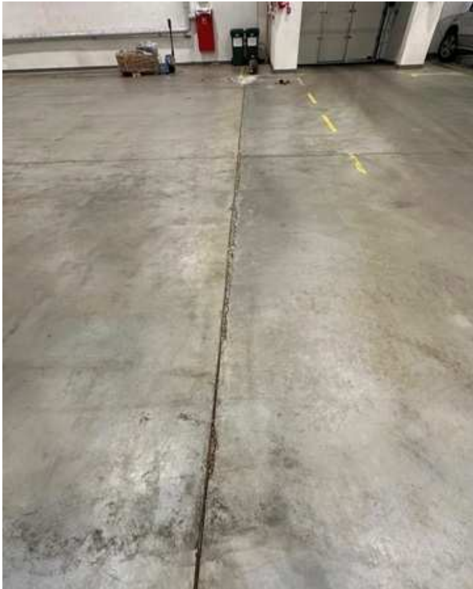
Fotografia 1 Uszkodzona dylatacja w osi 4
