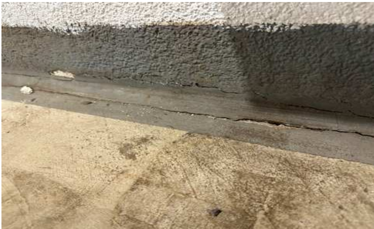
Fotografia 3. Uszkodzone wyoblenia na połączeniu podłogi ze ścianą- do usunięcia i odtworzenia
