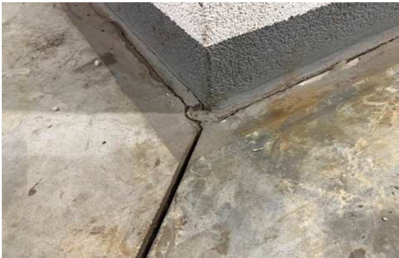
Fotografia 3. Uszkodzone wyoblenia na połączeniu podłogi ze ścianą- do usunięcia i odtworzenia
